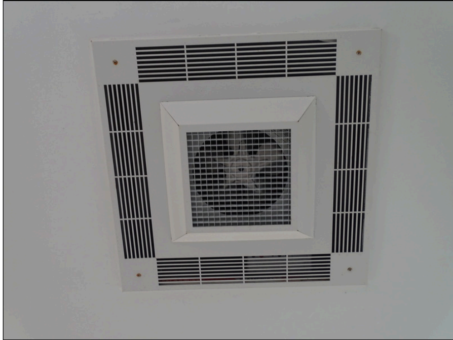
53 - Unit heater and exhaust fan
