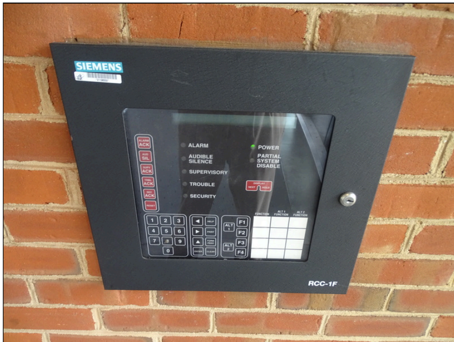
54 - Fire alarm annunciator
