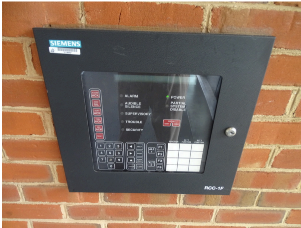
Fire alarm annunciator
